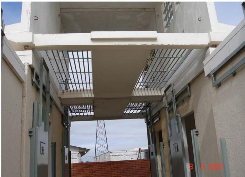
Figura 77 – Protótipo proposto pela fábrica: Dois conjuntos de celas e um módulo de passarela.
