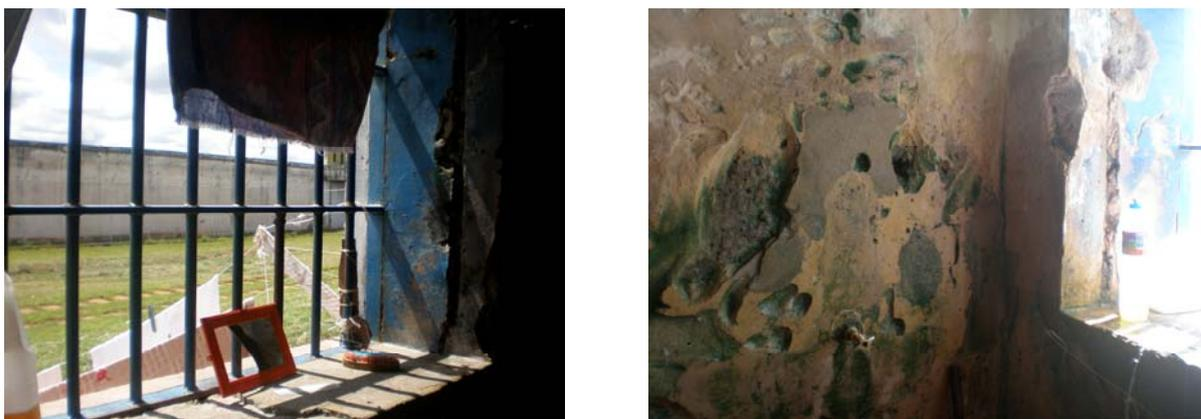
Figura 100 – Condições precárias das grades e das paredes
