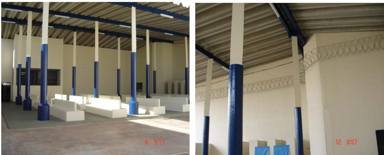
Figura 65 – Seção triangular dos pilares no pátio
