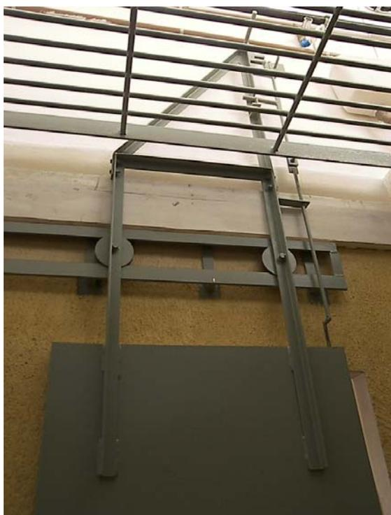
Figura 72 – Porta corredeira com acionamento pelo piso superior
