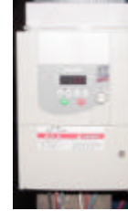
Figura 5.10: Conversor de frequência.
