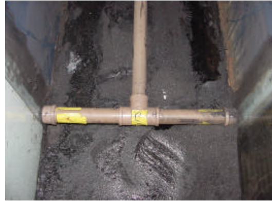
Figura 5.2: Difusor para admissão de mistura implantado no canal.
