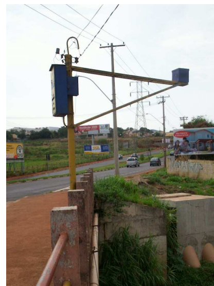
Figura 26: Detalhe lateral do posto. (Foto: TFS, 01/11/2007)
