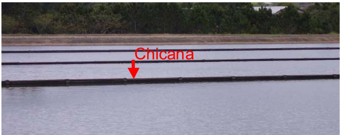
Figura 4: Chicanas do Sistema de Tratamento de Esgoto do município de Pariqueira-Açu.
