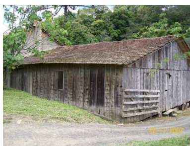
Imagem 65: Galpão. Fonte: Acervo do autor.
