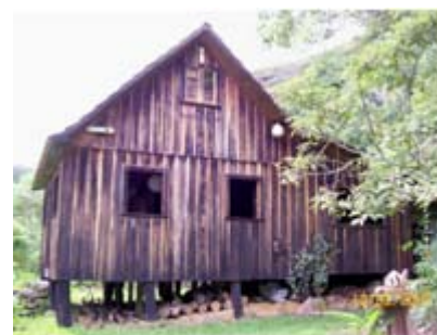
Imagem 55: Construção antiga. Fonte: Acervo do autor.
