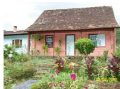
Imagem 67: Construção antiga. Fonte: Acervo do autor.
