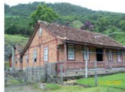
Imagem 71: Construção antiga. Fonte: Acervo do autor.
