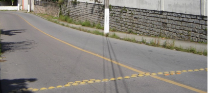
Foto 1: muros altos e pavimentação contínua nos passeios. Fonte da autora,
