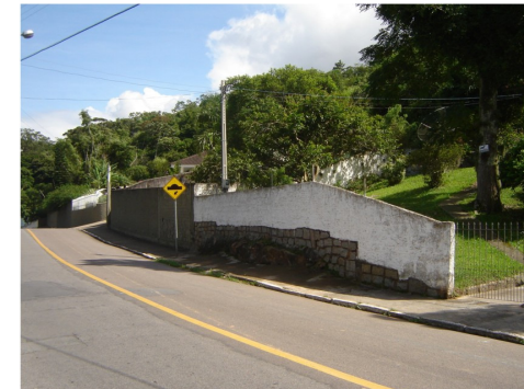
Foto 9 : trecho em que há permeabilidade da moradia para a rua. Fonte da autora, 2007.
