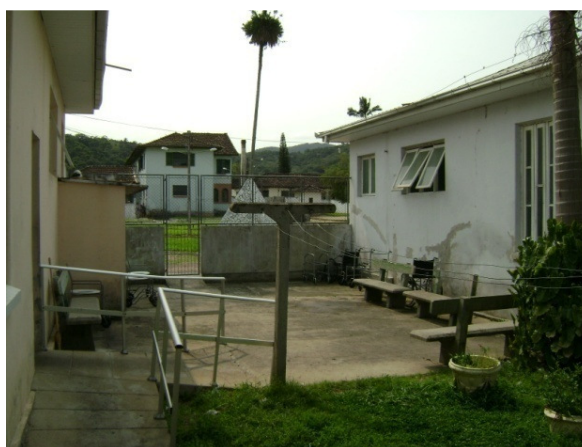
Fig. 45 – Rampa de acesso pátio interno feminino. Fonte: autora
