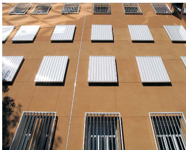
Fig. 81 – Parte externa da esquadria: emprego de brises verticais móveis. Fonte: Machado, 2005.
