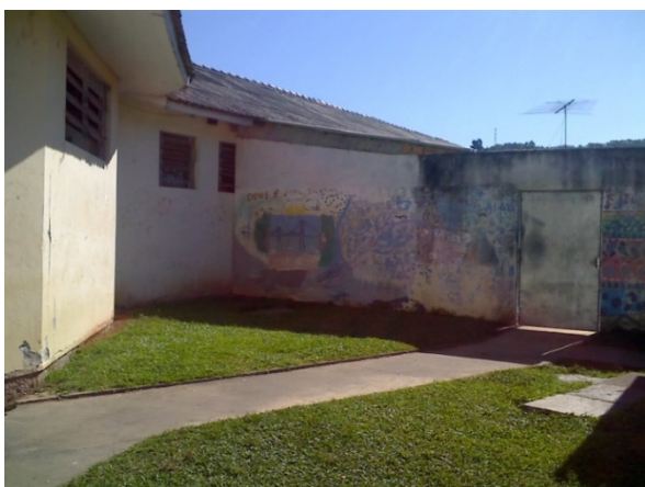
Fig. 43 – Caminhos no pátio da enfermaria masculina levam a portões raramente utilizados e muros recebem tentativa de criação de um mural. Fonte: autora
