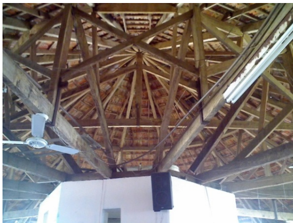
Fig. 61 – Estrutura do telhado do sombreiro. Fonte: autora
