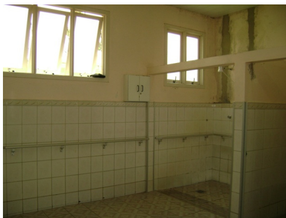
Fig. 40 – Barras de apoio junto ao boxe do banheiro feminino. Fonte: autora
