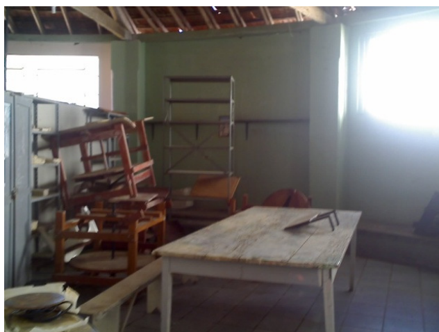
Fig. 64 – Área onde se armazenam muitos entulhos e móveis de outras enfermarias. Fonte: autora
