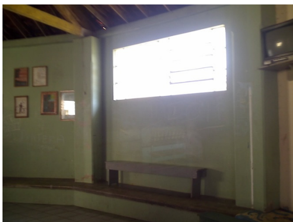
Fig. 62 – Bancos de madeira são utilizados para facilitar a visualização do exterior, devido ao peitoril alto das esquadrias. Fonte: autora
