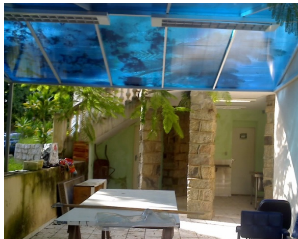
Fig. 71 – Área externa a sala de pintura.
