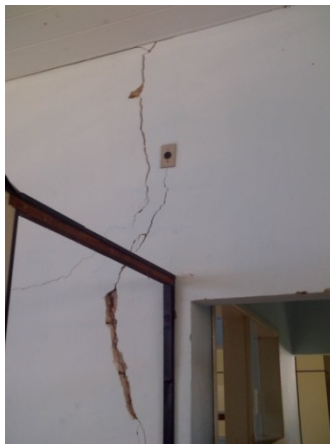
Fig. 33 – Rachadura e cor da parede em azul muito pálido, utilizada na enfermaria masculina. Fonte: autora
