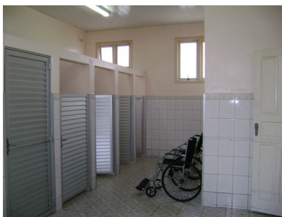
Fig. 56 – Cadeiras de roda armazenadas no banheiro feminino.
