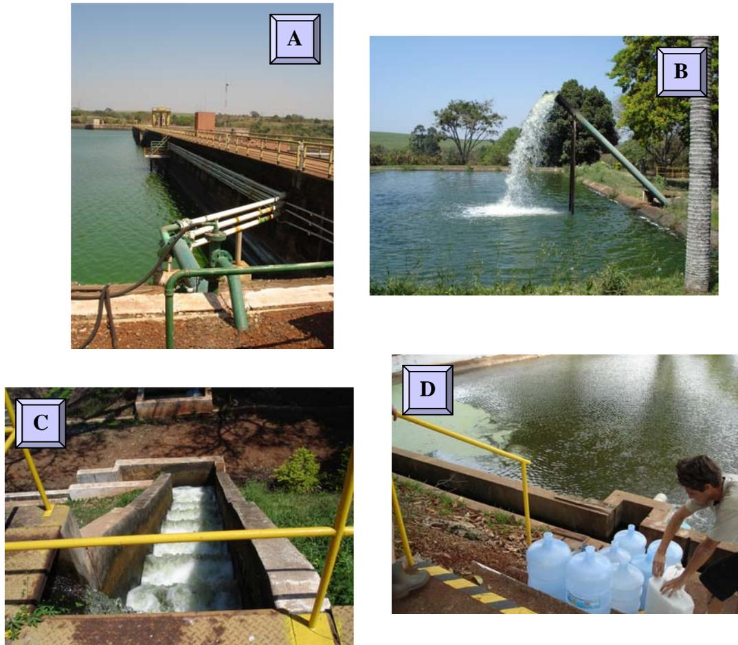
Figura 4.7: A) Bombeamento do Reservatório; B) Tanque de Armazenamento; C) Canaletas de Distribuição; D) Local de Coleta.
