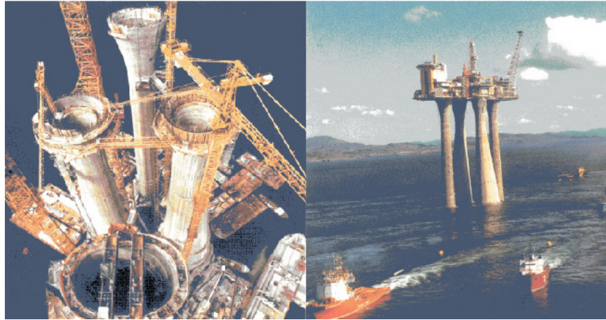
Figura 2.7 – Plataforma Fixa por Gravidade [14].
