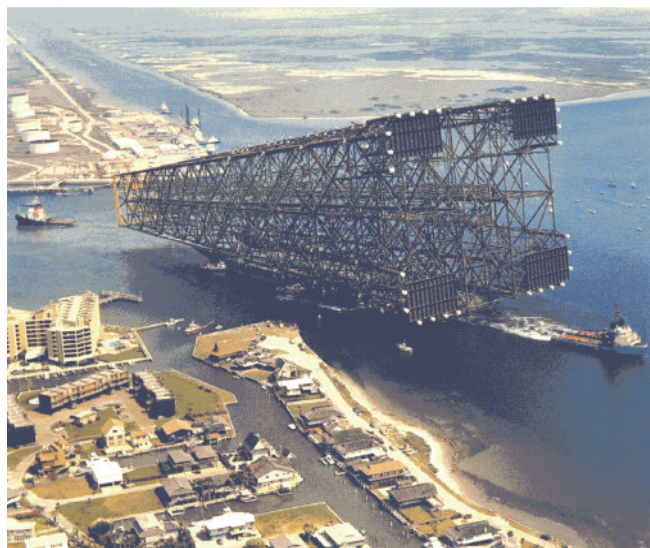
Figura 2.6 – Jaqueta da Bullwinkle – 412m [14].
