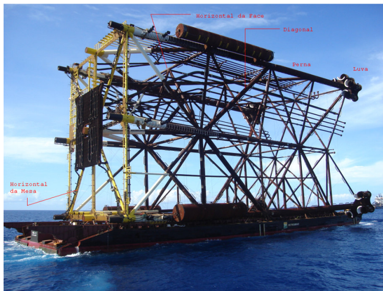
Figura 2.10 – PRA-1 durante o transporte (2007) – Elementos de uma jaqueta: Fonte Planave SA
