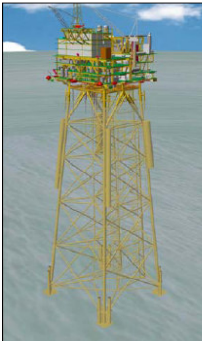
Figura 2.4 – Plataforma de Mexilhão: 172m de lâmina d'água
