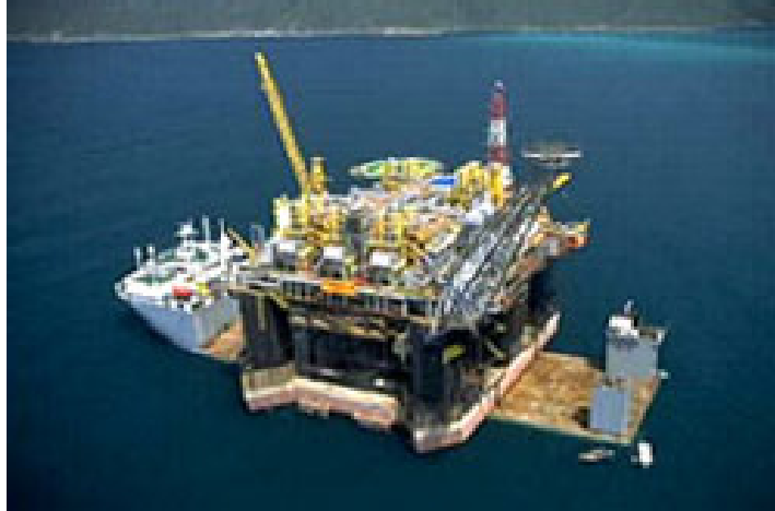
Figura 4. Plataforma semi-submersível sendo transportada para o local de instalação.
