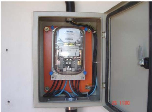
Figura 18 -Detalhe Watímetro.
