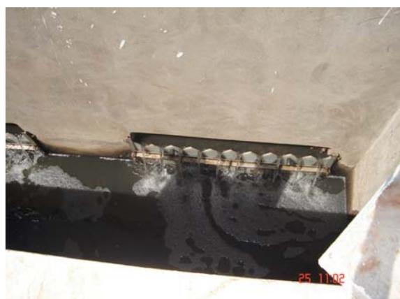
Figura 17 - Vertedores de saída-ponto de coleta de efluente
