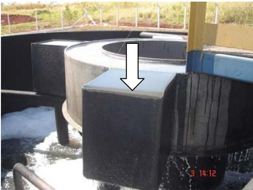
Figura 21 - Caixas distribuidoras de efluente do BAS extravasando no momento de acionamento da bomba.
