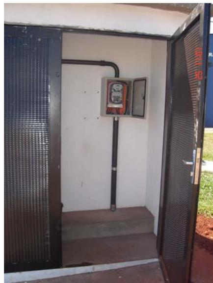
Figura 19 - Watímetro medindo energia elétrica consumida na Unidade UV.
