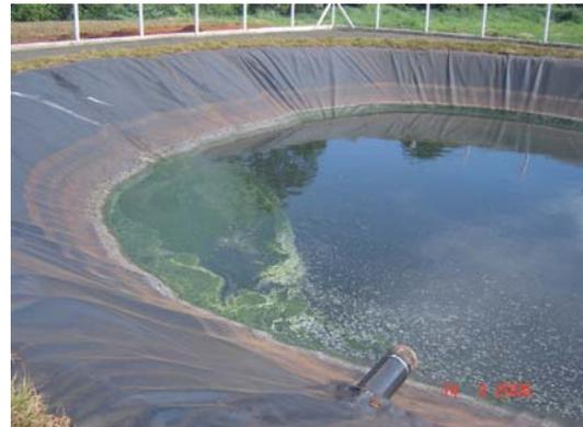
Figura 22 – Algas depositadas no tanque pulmão que eram carregadas para os reatores.
