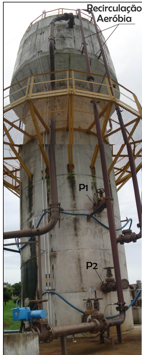
Figura 4.6 – Corrente recirculada aeróbia com câmara de solubilização e entrada no reator em dois pontos (P1 a 7,0m e P2 a 9,0m).
