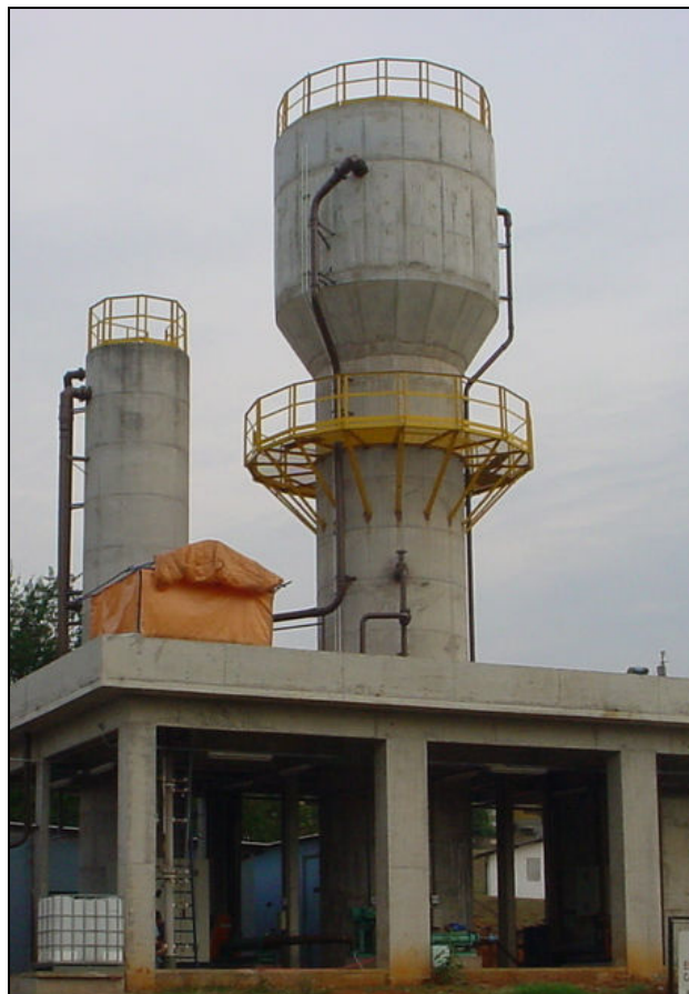
Figura 4.5 – Corrente recirculada aeróbia original, sem câmara de solubilização com entrada no reator em três pontos (6,0; 7,0 e 9,0 metros).
