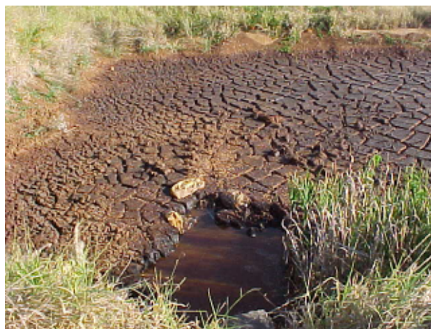
Figura 4.6 – Camada de água sob lodo seco em lagoas de lodo.
