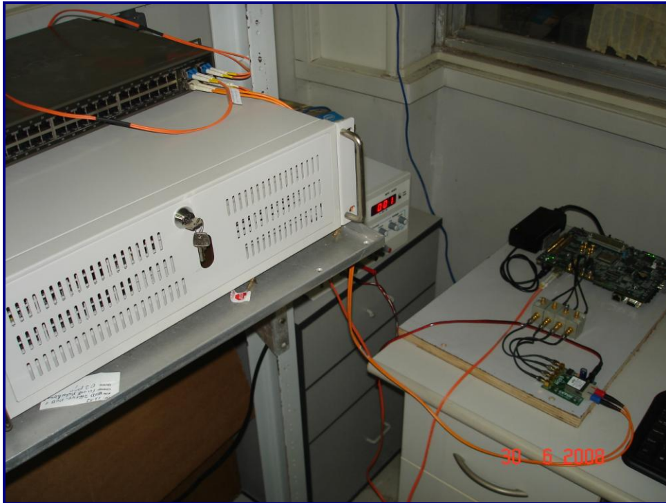
Figura 34 – Vista geral da montagem durante a realização dos testes
