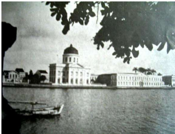
II.15 Foto antiga dos prédios destacados por Parahym (1977): a Assembléia Legislativa, o Ginásio Pernambucano e ainda o prédio da Repartição de Saneamento, às margens do rio Capibaribe. FONTE: Museu da Cidade do Recife, 2006.
