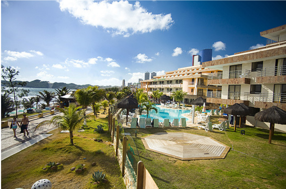
FIGURA 22: Fachada posterior (frente para o mar) do hotel “Esmeralda” Fonte: Esmeralda Praia Hotel 7 .
