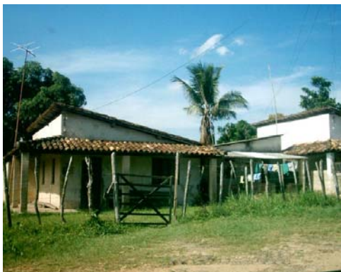
Foto 44 – NJK - Vila Camaçari: aspectos dos espaços construídos
