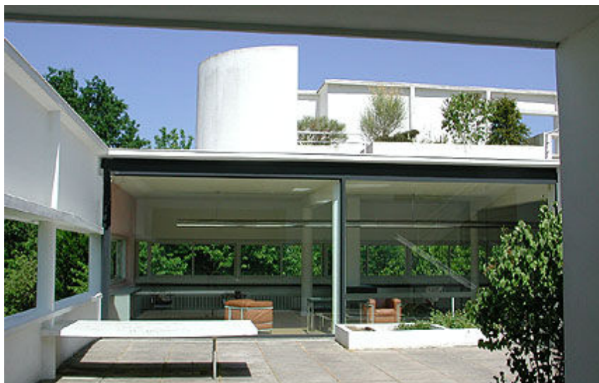
Figura 13 – Terraço da Villa Savoye , construída em 1928 (GALINSKY, 2008)
