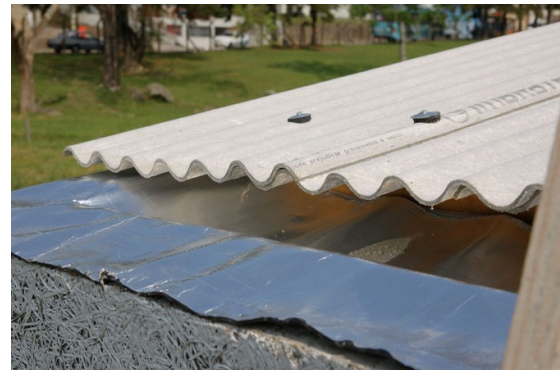
Figura 62 - Calha localizada na base da cobertura
