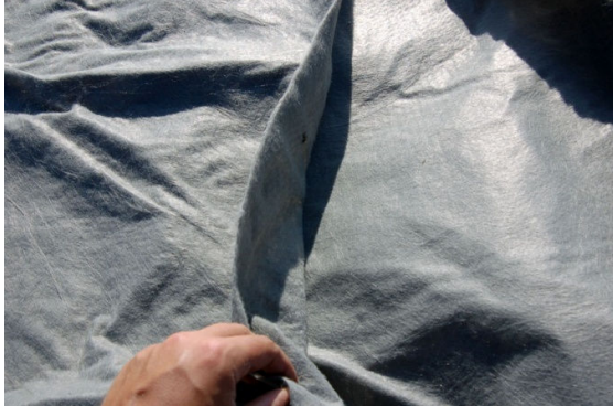
Figura 56 – Sobreposição de 20 cm da geomembrana
