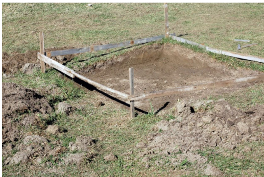
Figura 42 – Escavação e nivelamento
