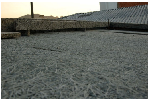
Figura 52 – Montagem das formas da laje
