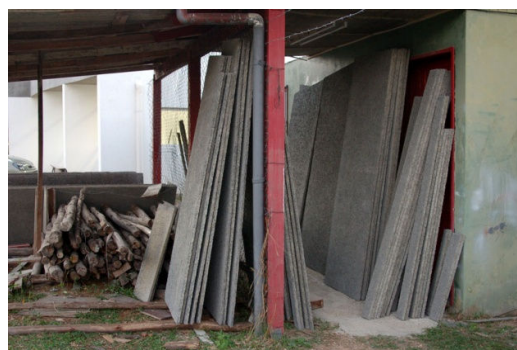
Figura 45 – Estocagem dos painéis, separados de acordo com suas características
