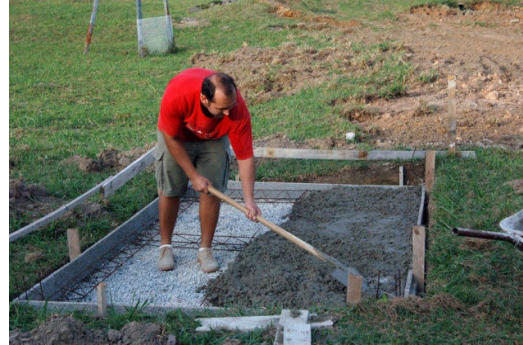
Figura 47 – Concretagem do radier
