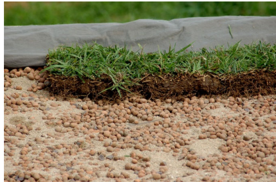
Figura 59 – Transplante das leivas do solo para a cobertura vegetal
