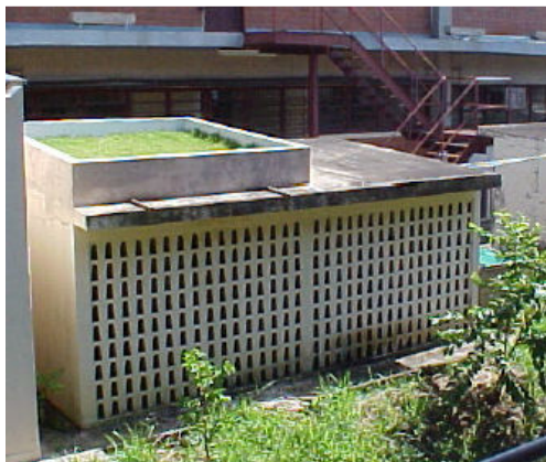
Figura 24 – Edificação para medições em São Carlos (MORAIS, 2004)
