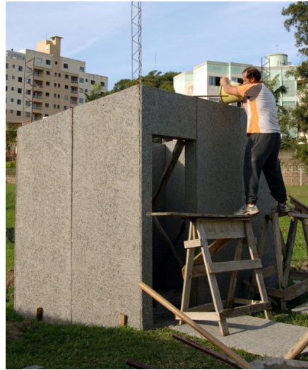
Figura 51 – Concretagem das vigas
