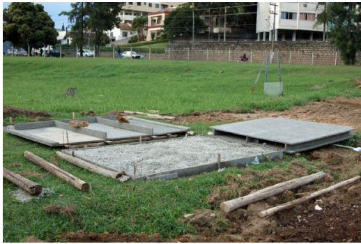
Figura 48 – Montagem no solo dos painéis
