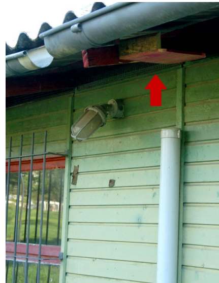
Figura 67 - Localização do HOBO® para medidas externas
