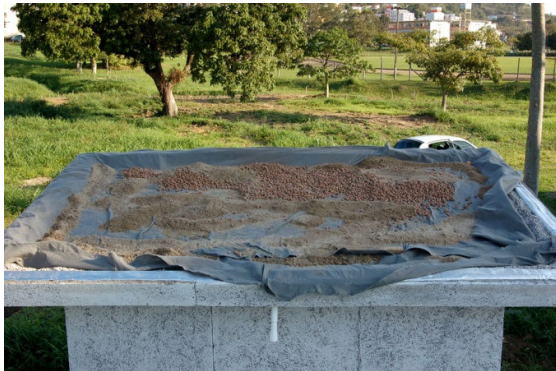
Figura 58 – Preparação da base da cobertura vegetal
