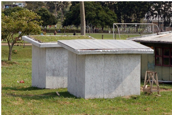
Figura 61 - Cobertura de fibrocimento
