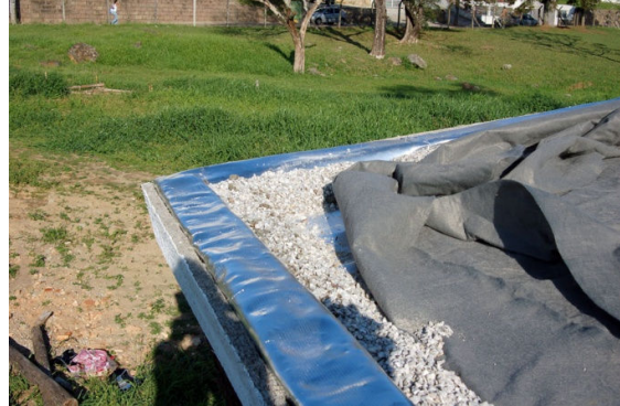
Figura 57 – Colocação da brita no perímetro da cobertura
