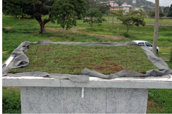
Figura 60 – Cobertura vegetal pronta
