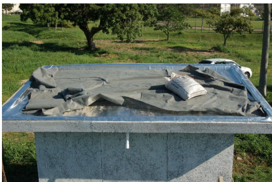
Figura 54 – Impermeabilização da cobertura vegetal
