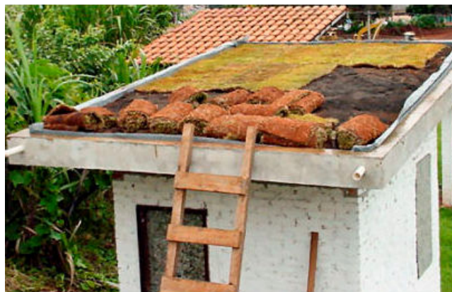
Figura 25 – Protótipos construídos na USP (VECCHIA et all , 2006)
