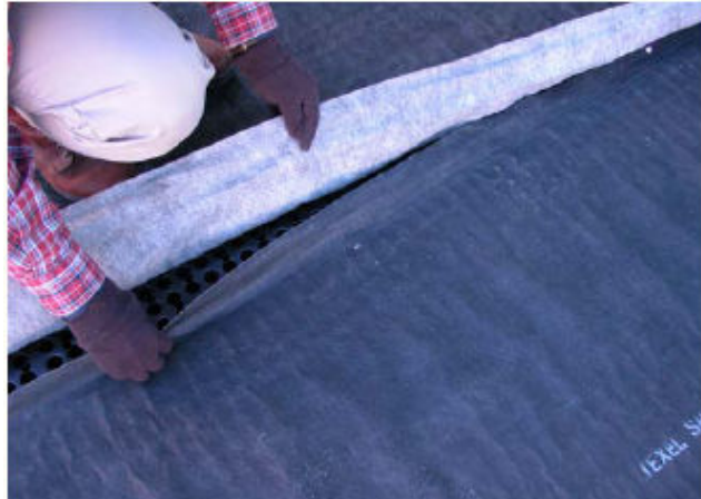
Figura 29 – Sobreposição da camada filtrante (Fonte: J-DRain GRS, 2006)
