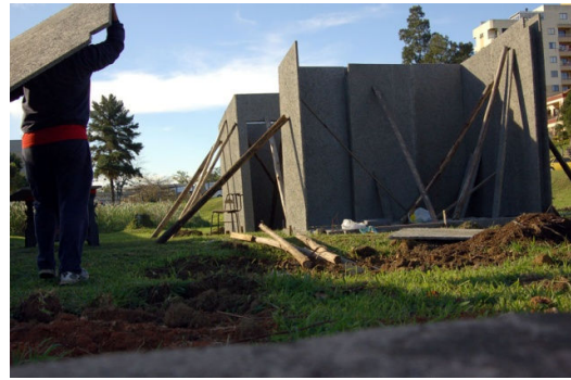
Figura 49 – Montagem dos painéis com escoras
