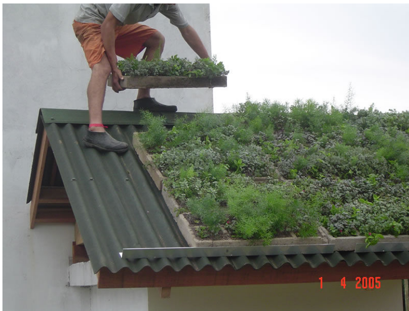
Figura 17 – Montagem da Ecotelha (Fonte: ECOTELHADO, 2006)
