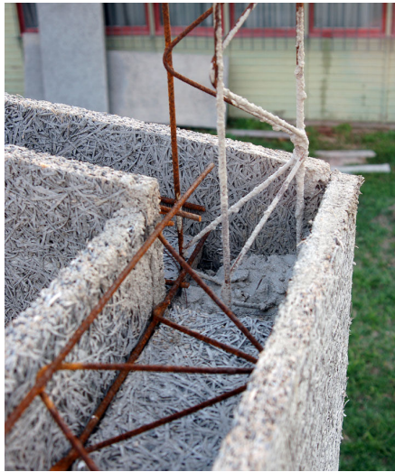
Figura 50 – Concretagem dos pilares
