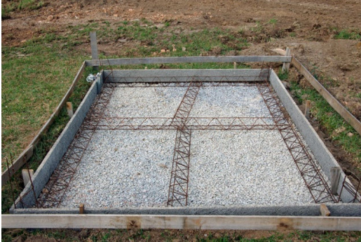
Figura 46 – Fôrmas e ferragens do radier
