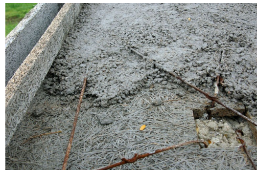
Figura 53 – Concretagem da laje e sua ferragem
