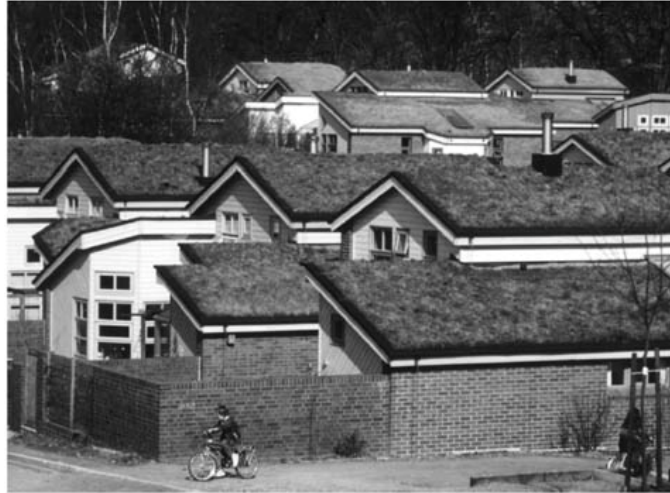
Figura 27 – Condomínio em Dössel, Alemanha, com coberturas verdes. Projeto dos arquitetos Bookhoff e Rentrop (Fonte: MINKE, 2001)
