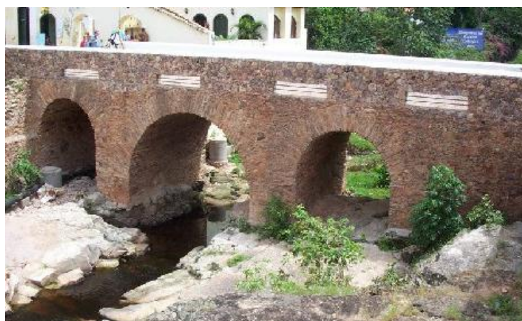
Figura 3.34: Vista da ponte sobre o rio Lençóis em 2004
