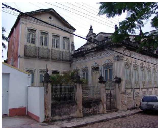
Figura 3.39: Casa térrea e sobrado.
