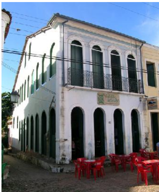
Figura 3.40: Fachada principal e lateral do sobrado
