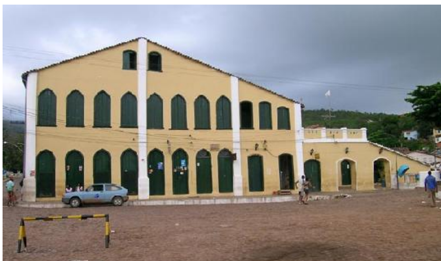
Figura 3.43: Fachada lateral, Praça Aureliano Sá
