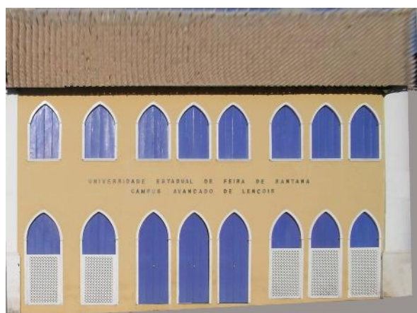
Figura 4.18: Ortofoto da edificação onde funciona o Campus da UEFS
