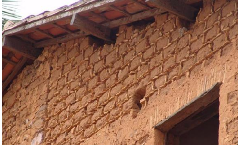
Figura 3.21: Casa construída em adobe
