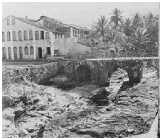
Figura 3.33: Vista da ponte sobre o rio Lençóis em 1978
