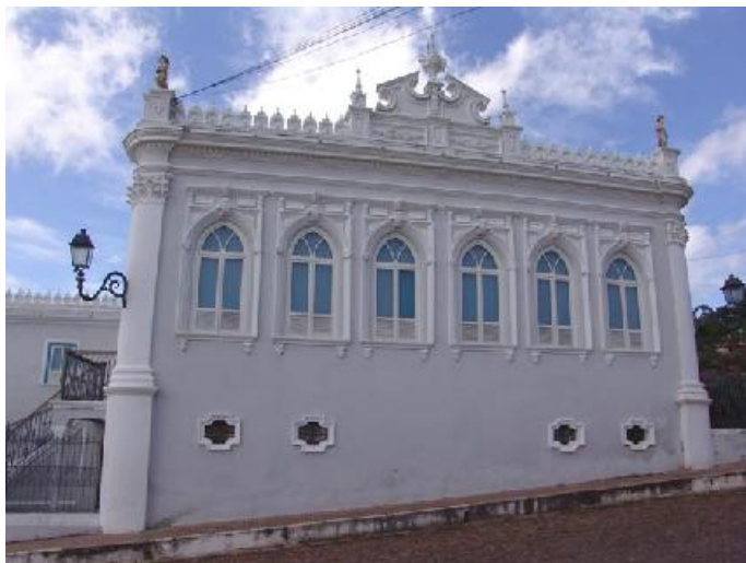
Figura 3.37: Fachada lateral da prefeitura, Av. Sete de Setembro.
