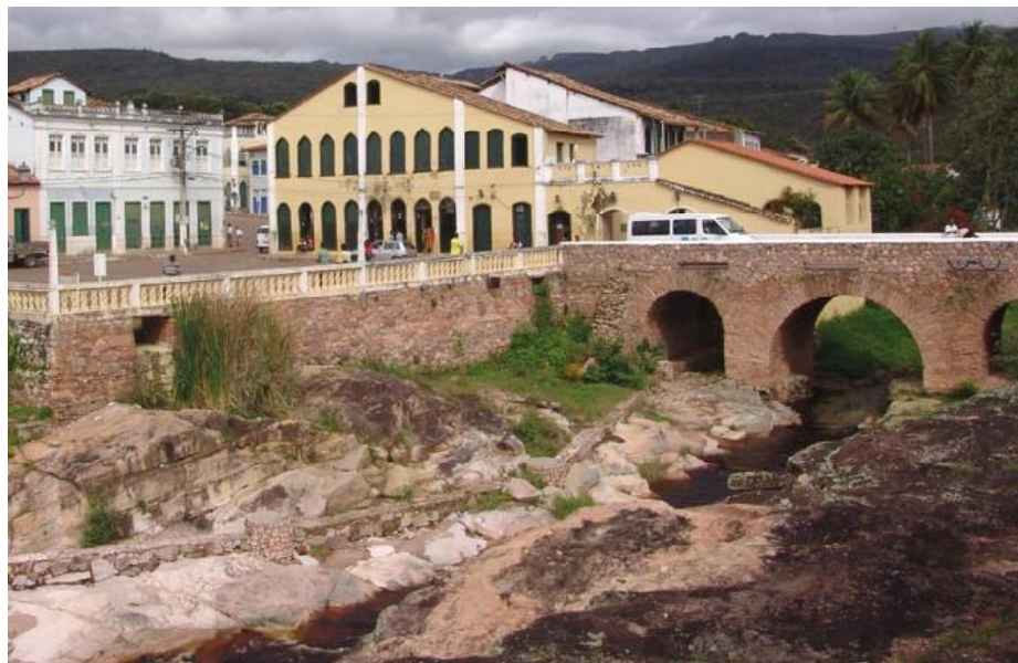
Figura 3.18: Vista do Rio Lençóis com a ponte que dá acesso ao centro
