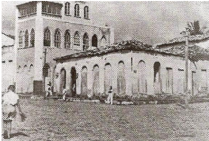
Figura 3.23: Edificação demolida para construção de agência do Banco do Brasil
