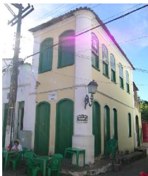
Figura 3.42: Fachada principal e lateral do sobrado
