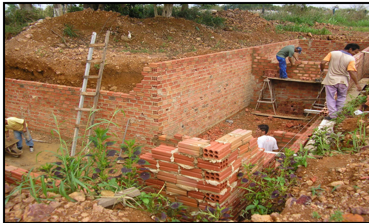
Foto 3.10: Construção da célula para depósito do lixo hospitalar
