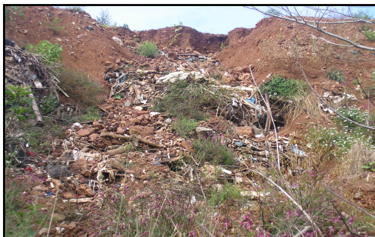
Foto 3.8: Sulco erosivo no talude de lixo em direção às nascentes
