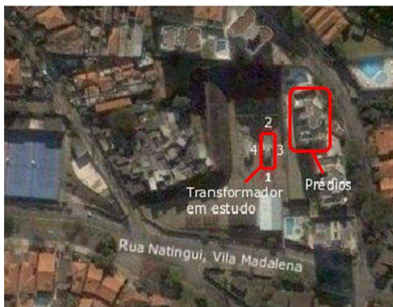
Figura 4.4: Localização da Subestação Bela Aliança
