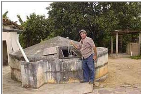
Figura 3.10 - Cisterna utilizada no nordeste brasileiro para armazenar água de chuva
