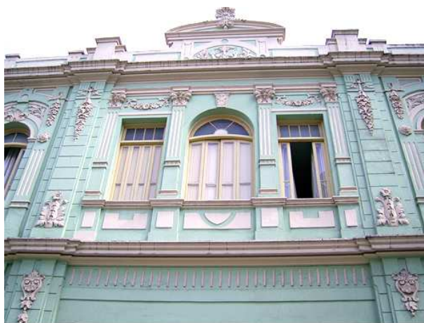
FIGURA 15 - Rua dos Caetés nº 245 a 263. Estilo Eclético 1ª fase com influência neoclássica. Data da construção: 1912. Foto: 02/04/2007. Crédito: Maria Elisa Rodrigues Moreira
