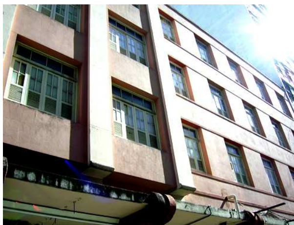
FIGURA 18 - Rua Espírito Santo nº 284. Tomada a partir da Rua dos Caetés. Estilo Art Déco. Data de construção: 1930/1940. Foto: 02/04/2007. Crédito: Maria Elisa Rodrigues Moreira
