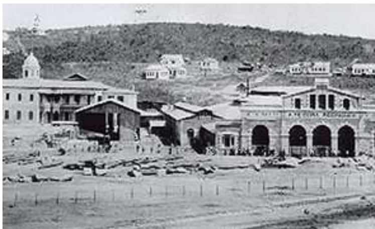
FIGURA 2 – Galpões do Grande Empório Central, do Conde de Santa Marinha, um dos grandes empreiteiros da construção de Belo Horizonte. Região da Praça da Estação. Final do século XIX.
