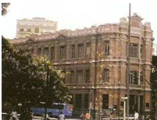
FIGURA 16 - Av. Amazonas, nº 478. Estilo eclético 1ª fase com influência neoclássica. Data da construção: 1919. Fonte: CASTRO (2006, p. 120).
