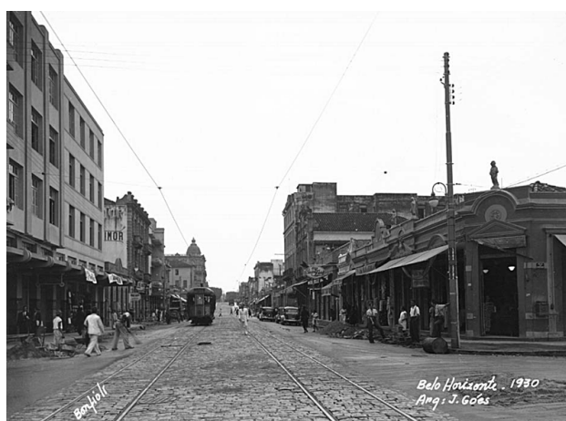
FIGURA 30 - Tomada da Rua dos Caetés a partir da Rua Espírito Santo, no sentido do Bairro da Floresta. 1930.
