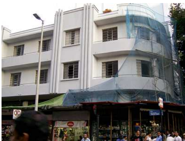
FIGURA 54 - Restauração da Casa Sales – Rua dos Caetés esquina com Rua São Paulo, 08/06/2007 Crédito: Maria Elisa Rodrigues Moreira
