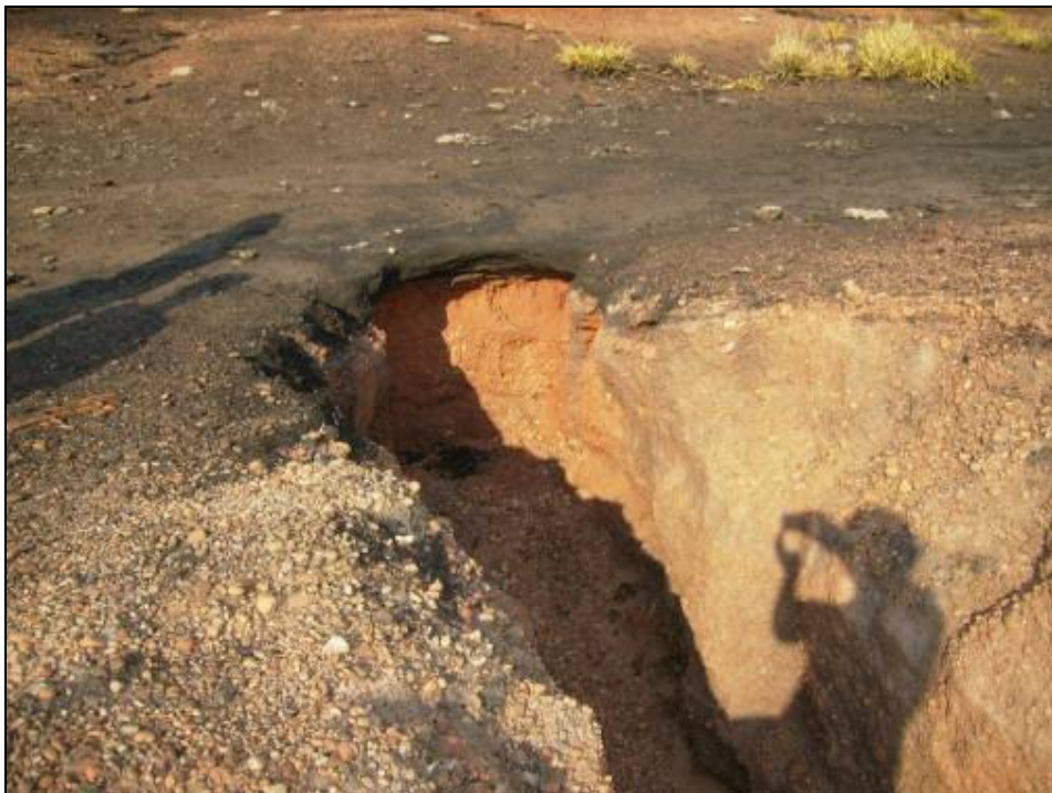
Foto 12 – Início do processo erosivo – Voçoroca Autor: SANTOS,C.R. Setembro/2007
