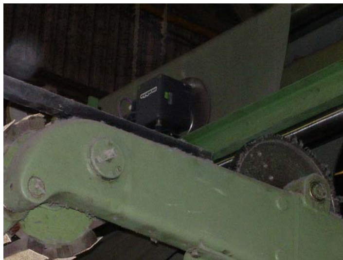
FIGURA 22 – Detalhe do sensor ótico na saída da sanforizadeira.
