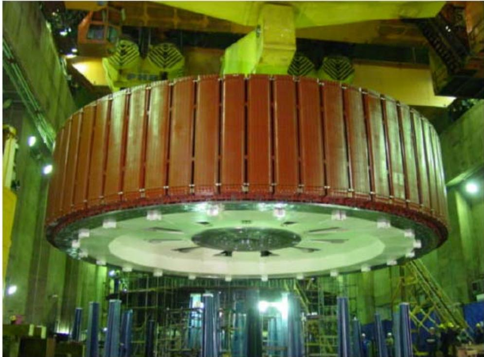
**Fig. 1.14** – Usina de Itaipu: rotor do gerador.
