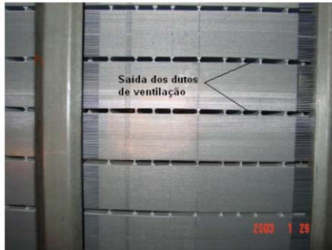
**Fig. 1.18** – Usina de Itaipu: vista do costado do núcleo.
