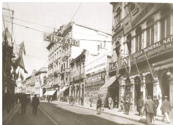
Figura 16. Praça Antônio Prado no ano de 1920 com intensa atividade comercial e novos formatos publicitários.
