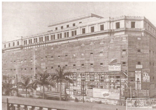
Figura 43. Prédio da Light em 1928, com inúmeros anúncios nos tapumes da construção.
