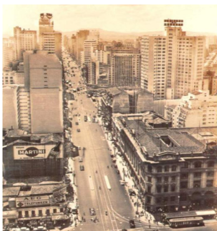
Figura 55. Avenida São João: inúmeras edificações contendo luminosos e anúncios.
