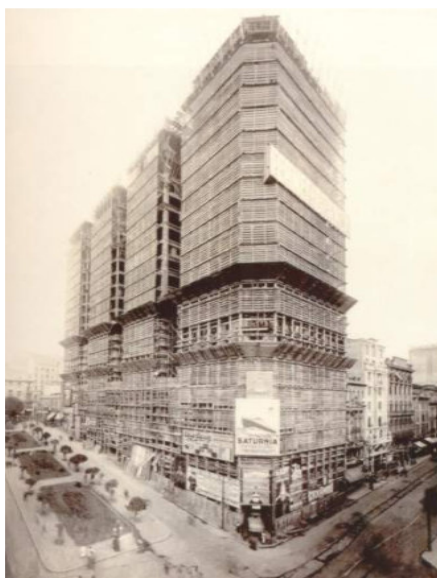
Figura 26. Edifício Martinelli em construção no ano de 1928. Destaque para a mídia exterior presente em sua estrutura com vários anúncios publicitários.
