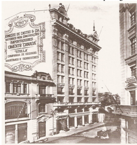
Figura 42. Edifício Ernesto de Castro com anúncio publicitário em parede lateral.
