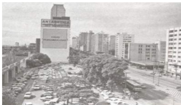
Figura 64. Ocupação da mídia exterior, que teve suas dimensões ampliadas com o passar dos anos, em formato de empena-cega, cobrindo laterais de edifícios.
