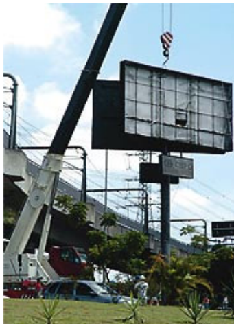
Figura 94. Backlight da Avenida João Dias sendo retirado na capital. Fonte: Fernando Pereira/Agência Estado.
