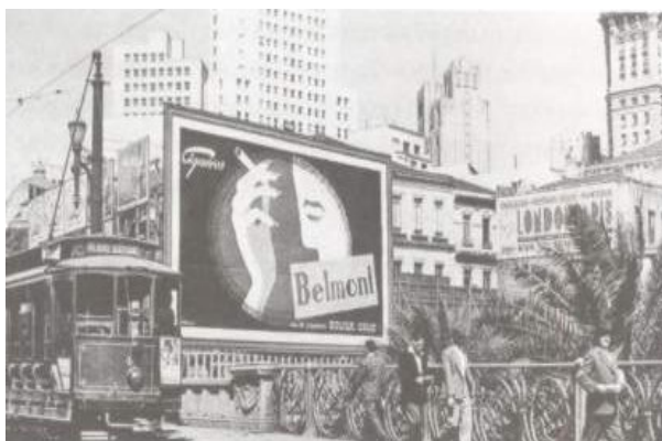
Figura 34. Anúncio publicitário em estrutura de madeira no Viaduto Santa Ifigênia com o início das empresas de outdoor .
