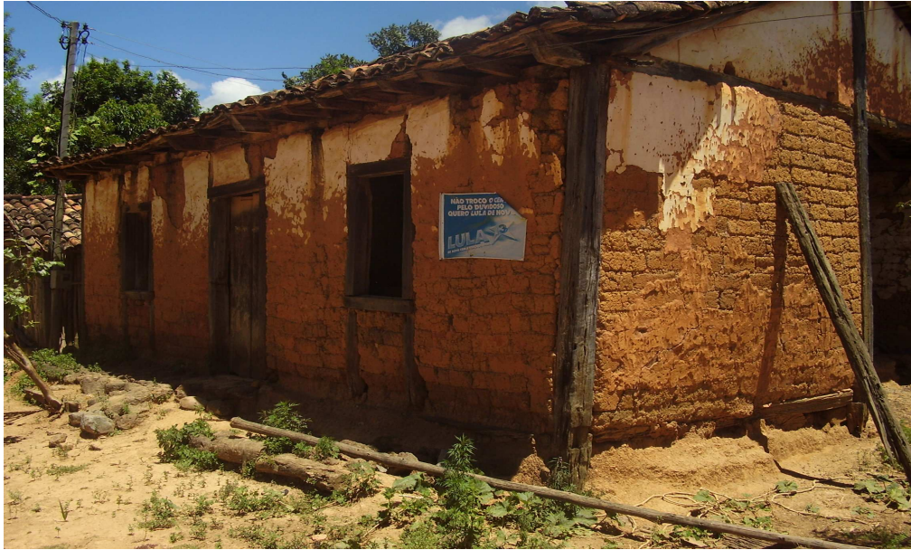
Foto 13: Comunidade de Pau D'Óleo, Montes Claros/MG : antiga casa de adobe um geraizeiro. A casa data do século XIX, construída pelo avô do entrevistado. Autor: AFONSO, P.C.S., ago/2007.
