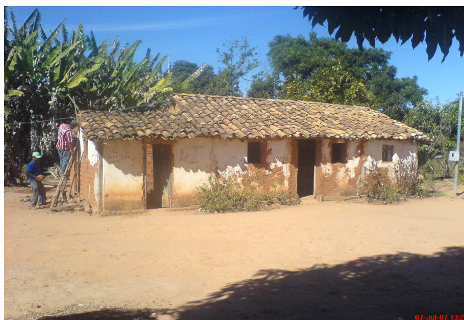
Foto 8: Comunidade de Lagoa do Barro – Montes Claros/MG: casa de adobe em fase de reforma, com a ampliação da cozinha e construção de um pequeno banheiro. A parte reformada será de tijolos e cimento e coberta com telhas de fabricação industrial.
