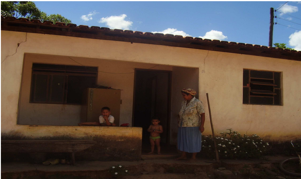
Foto 14: Comunidade de Pau D'Óleo, Montes Claros/MG: casa atual construída para o maior conforto da família (conforme aponta o entrevistado). A construção data dos anos 1980. Observa-se características mais modernas como portas e janelas de metalon e vidro, telhas industriais, tijolo e cimento. Autor: AFONSO, P.C.S., ago/2007.
