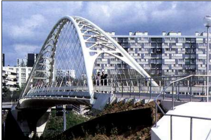
Figura 1.2 - Passarela Oudry-Mesly [2]– França.
