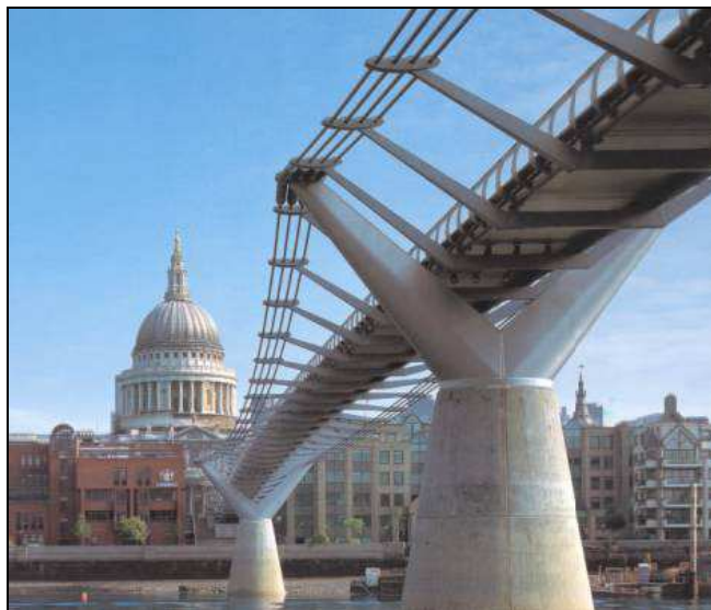
Figura 1.1 – Vista Inferior do tabuleiro e pilares de suporte da Passarela do Milênio [1] em Londres – Inglaterra.
