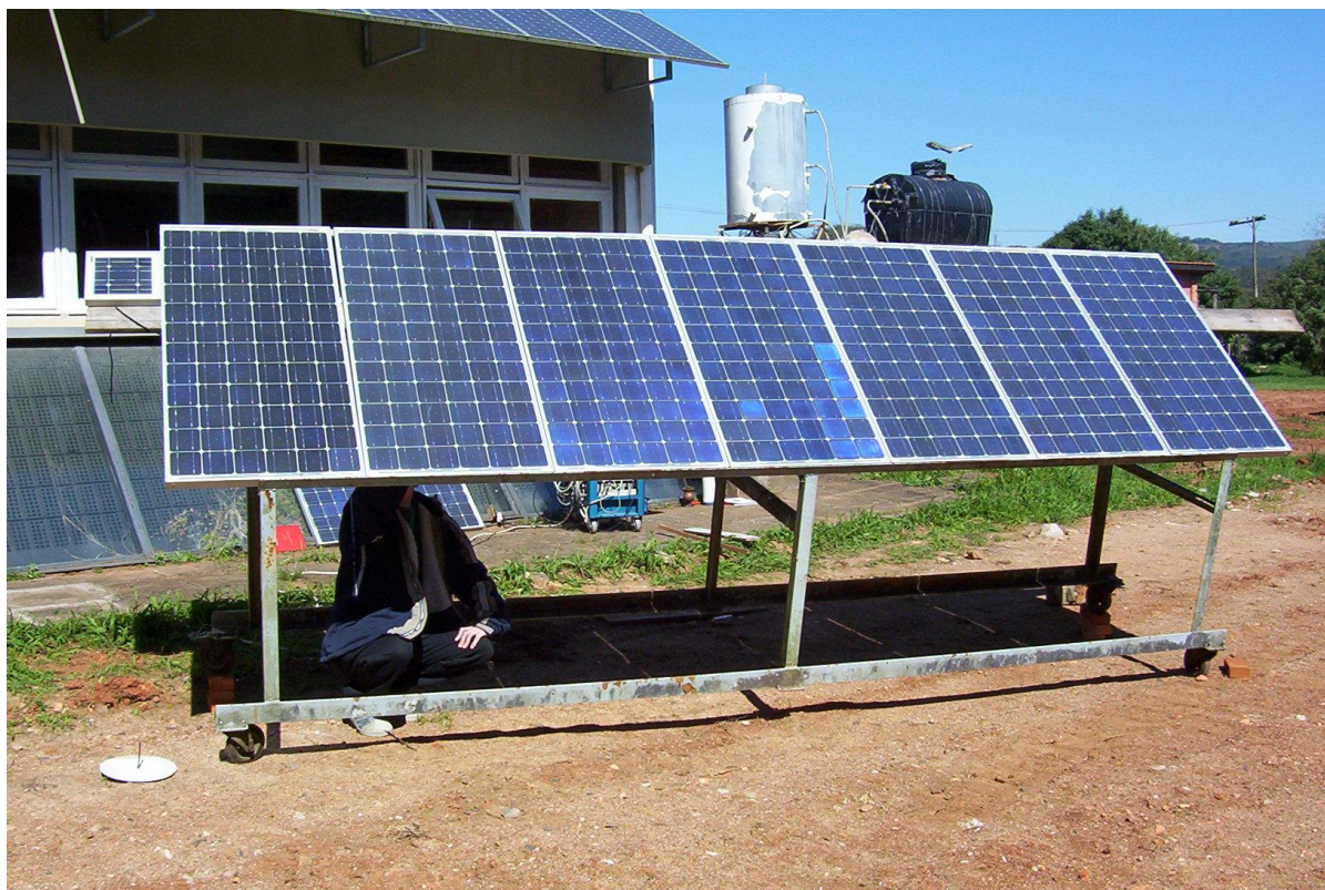
Figura 5.1 - Aspecto do ensaio de módulos sob iluminação natural.
