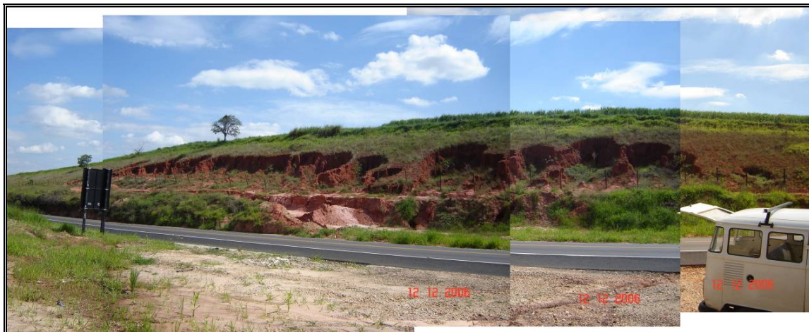
Figura 4.9 - Boçorocas de beira de estrada
