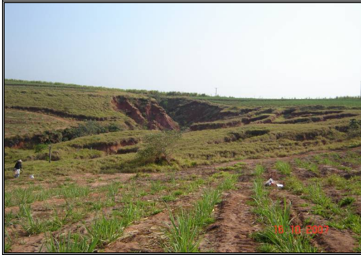
Figura 4.46 – Boçoroca de jusante para montante.
