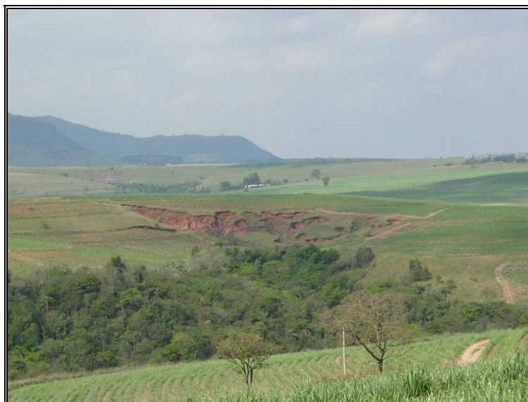
Figura 4.7 - Feição erosiva em processo ativo.
