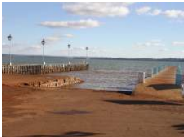
Figura 29- Parque de Lazer Annita Wanderer – rampa para barcos de acesso ao Lago de Itaipu.
