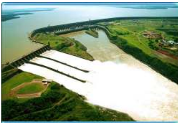
Figura 3: Vista geral da Hidrelétrica de Itaipu em Foz do Iguaçu – PR.
