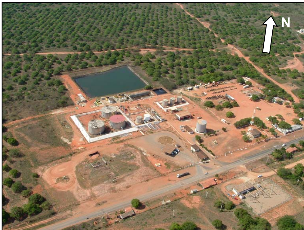
Figura 5.2 – Vista aérea panorâmica da ETO/ETE do Campo de Fazenda Belém -CE.
