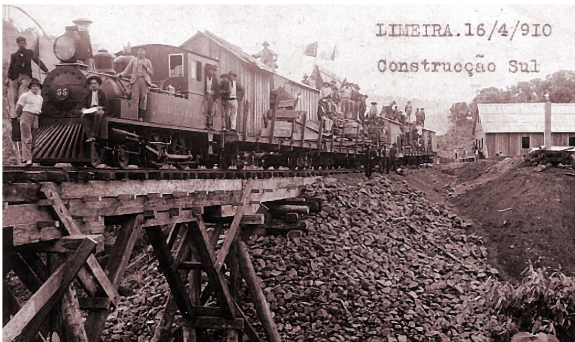
Imagem 3: A construção da Linha Sul chega a Limeira. Abril de 1910.
