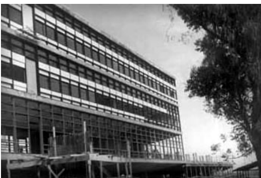
Figura 20 – Construção Bloco E1
