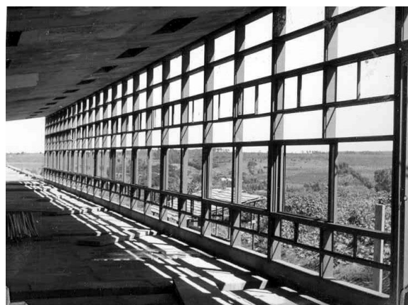
Figura 31 – Construção Bloco E1
