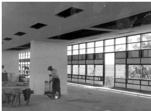
Figura 23 – Construção Bloco E1
