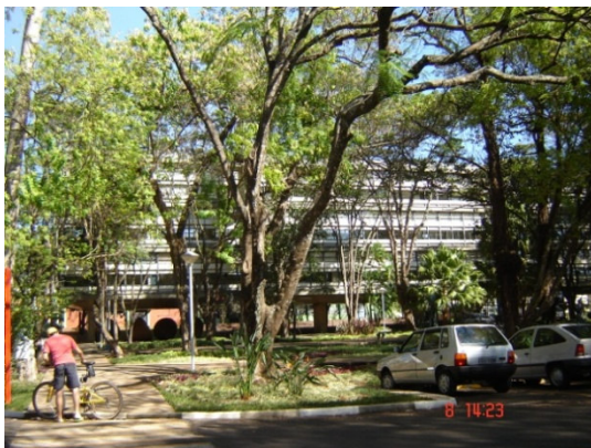
Figura 44 – Fachada norte do Bloco E1
