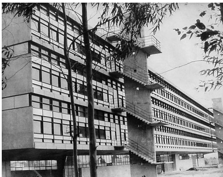
Figura 8 – Bloco E1 – Primeiro edifício a ser construído no campus da EESC Fonte – BLOCO E1: fotos diversas (2005)
