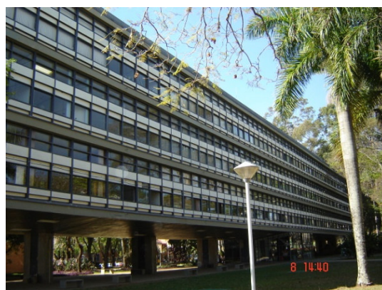
Figura 47 – Fachada sul do Bloco E1
