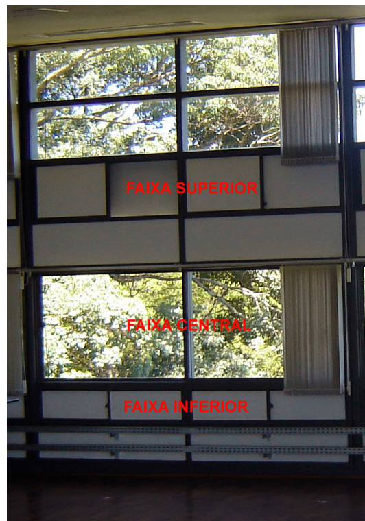
Figura 67 – Módulo de janela do Bloco E1
