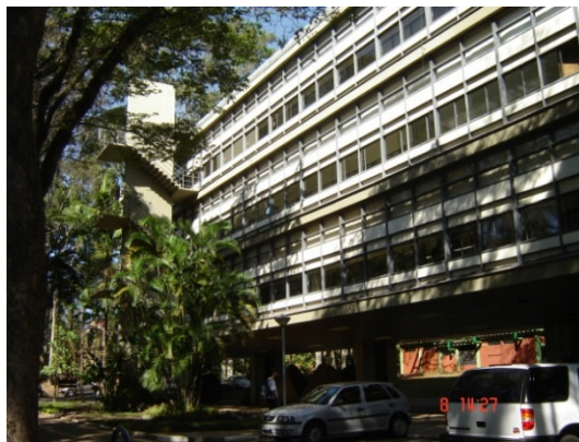
Figura 45 – Fachada norte do Bloco E1
