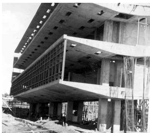
Figura 30 – Construção Bloco E1
