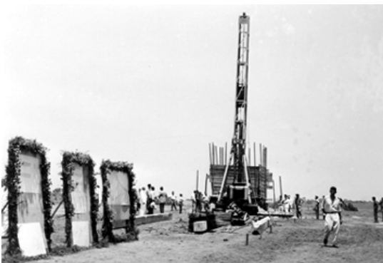
Figura 18 – Estaca Bloco E1
