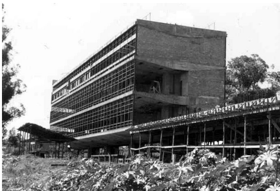
Figura 22 – Construção Bloco E1
