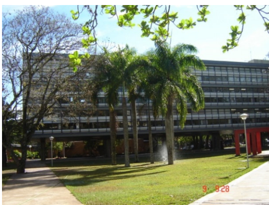
Figura 46 – Fachada sul do Bloco E1
