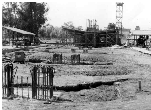
Figura 19 – Construção Bloco E1
