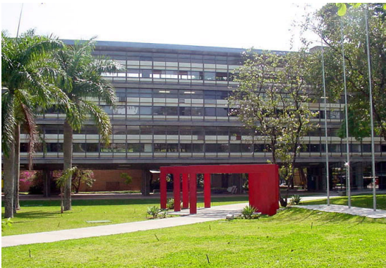
Figura 27 – Fachada Bloco E1
