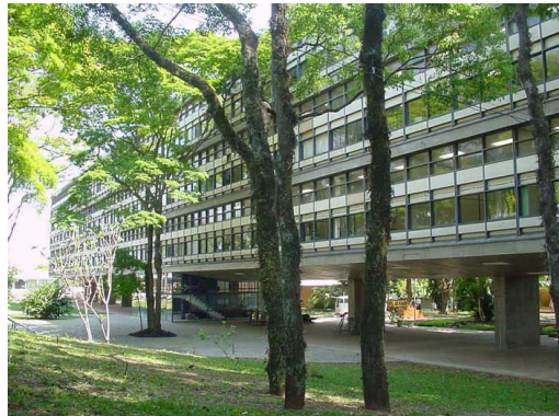
Figura 28 – Fachada Bloco E1
