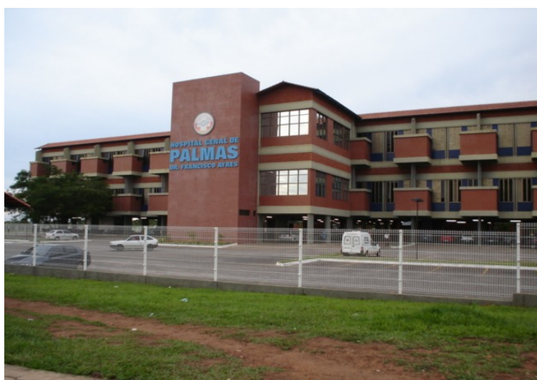
Figura 24: Hospital Geral de Palmas. Fotografia tirada em setembro de 2006.
