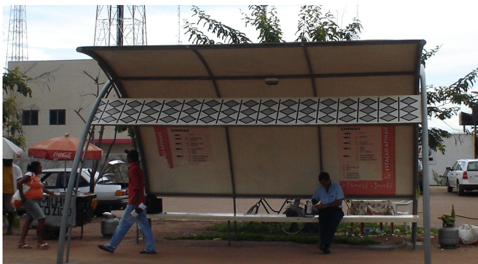
Figura 83: Estação Apinajé. Fotografia tiradas em fevereiro de 2008.
