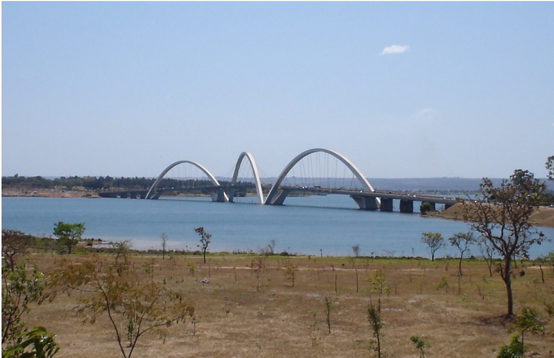
Figura 16: Ponte JK (Brasília - DF). Fotografia tirada em setembro de 2007.
