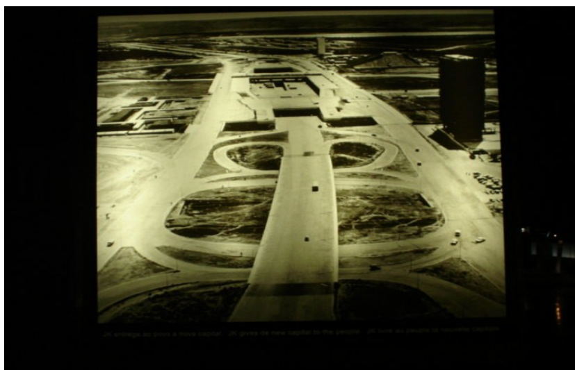
Figura 21: Início da construção de Brasília - Fotografia exposta no Museu JK (Brasília - DF) Reprodução realizada em outubro de 2006.
