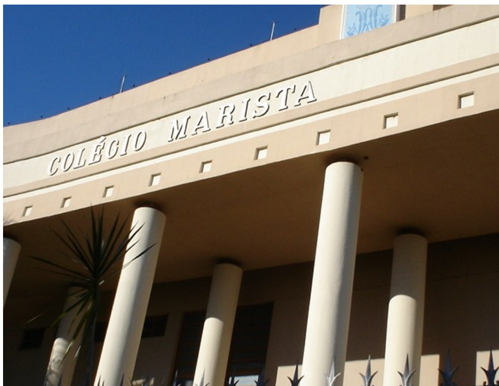
Figura 26: Detalhe da edificação. Fotografia tirada em setembro de 2006.
