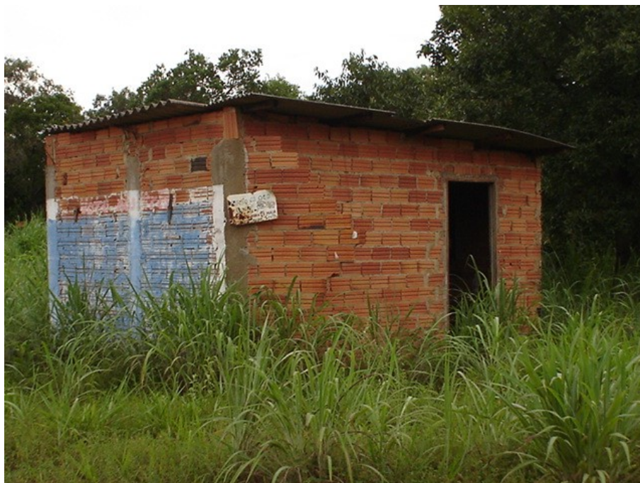
Figura 44: Quadra 605 Sul, ruínas do in concreto - construção abandonada. Fotografia tirada em 12 de janeiro de 2007.
