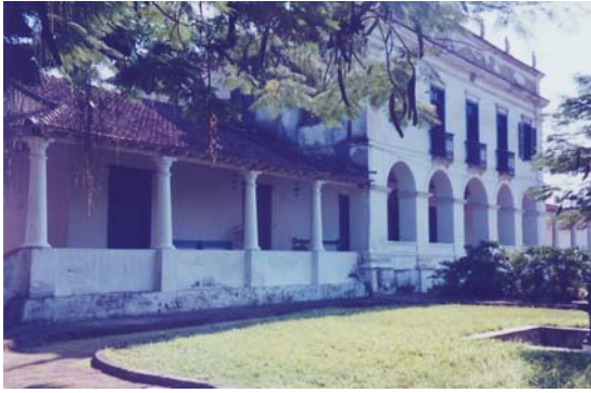
II.17. Fazenda da Taquara lado esquerdo da fachada frontal
