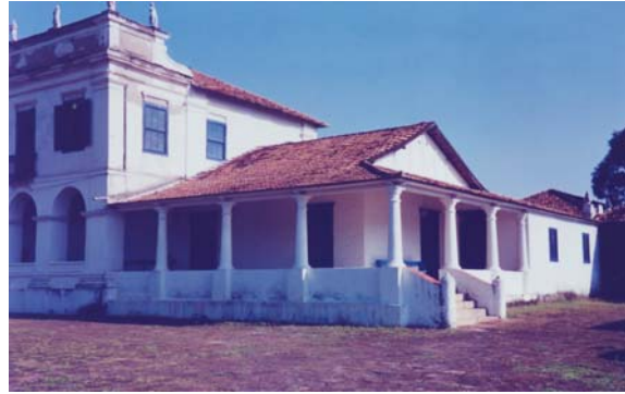
II.18. Fazenda da Taquara lado direito da fachada frontal
