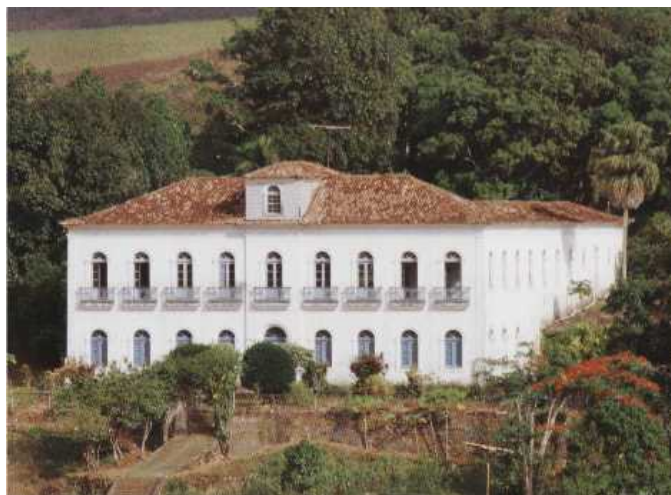
II.15. Engenho Gaiapó, Ipojuca
