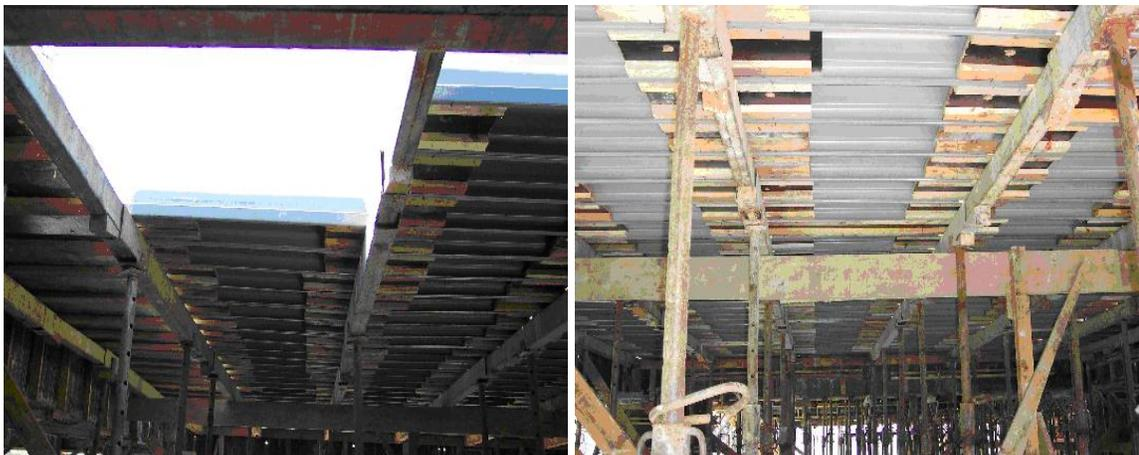
Figura 2.4 - Esquema estrutural de escoramento.
