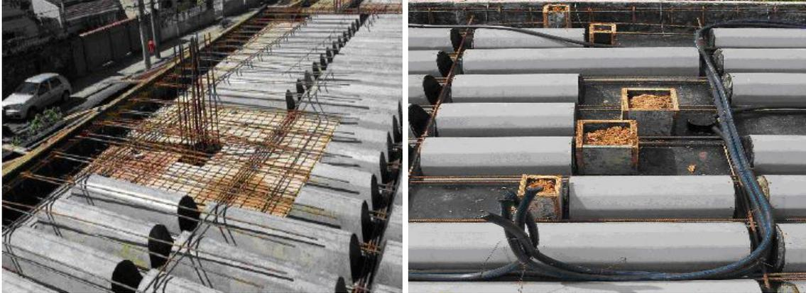
Figura 2.5 - Sistema de laje nervurada com trechos de laje maciça e de meio barrote.
