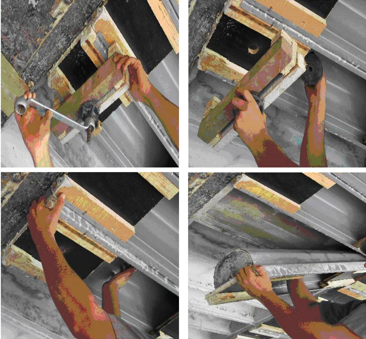
Figura 2.6 - Processo de desforma dos barrotes.
