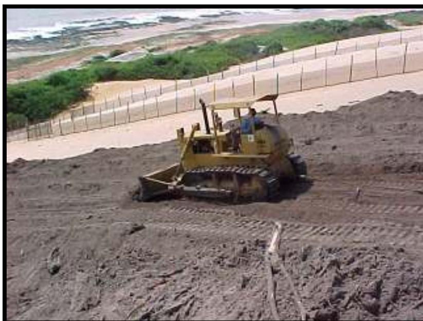
**Figura 4.3 – Recapeamento. Espalhamento do *topsoil* (solo rico em matéria orgânica e nutrientes) nas dunas de rejeito para posterior reflorestamento.**
