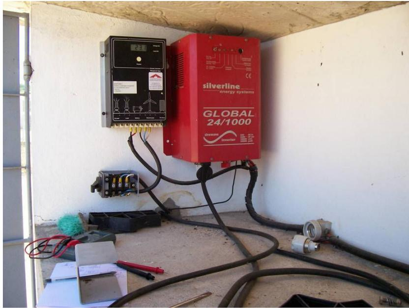
**Figura 33 - Foto do Inversor de Frequência e Controlador de Carga do modelo.**
