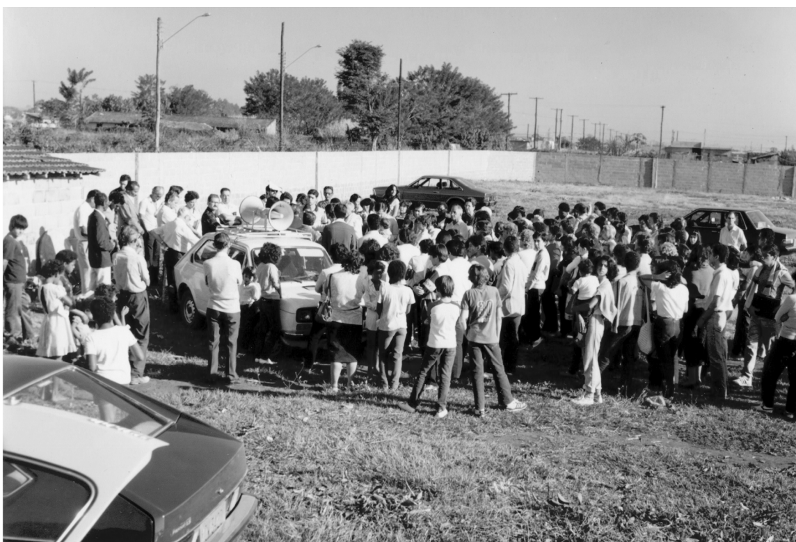
Lançamento da Pedra Fundamental do Lar da Criança e Creche Vinde Meninos 19 de junho de 1984
