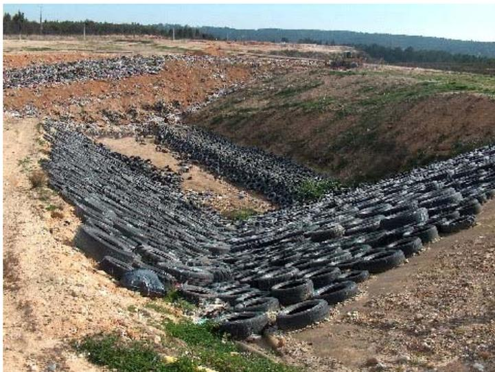
**Figura 2.5:** Aterros para Disposição de Pneus Inservíveis
