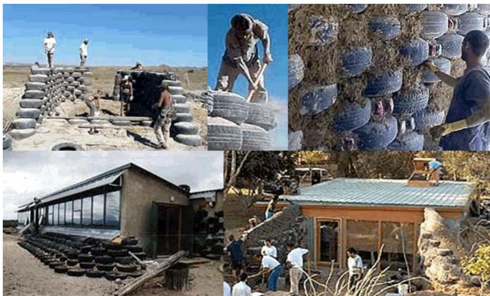
**Figura 2.6:** Construção de Edificações com Pneus (ODA, 2003)
