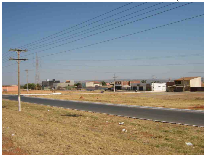
Figura 10 – Foto ilustrativa da área urbana consolidada (Condomínio Prive)
