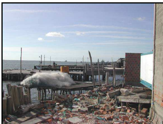
Figura 4.35- Margem densamente ocupada por piers e bastante poluída.
