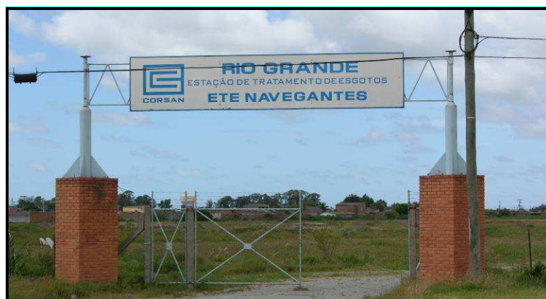
Figura 4.31- Estação de tratamento de esgotos de Rio Grande.
