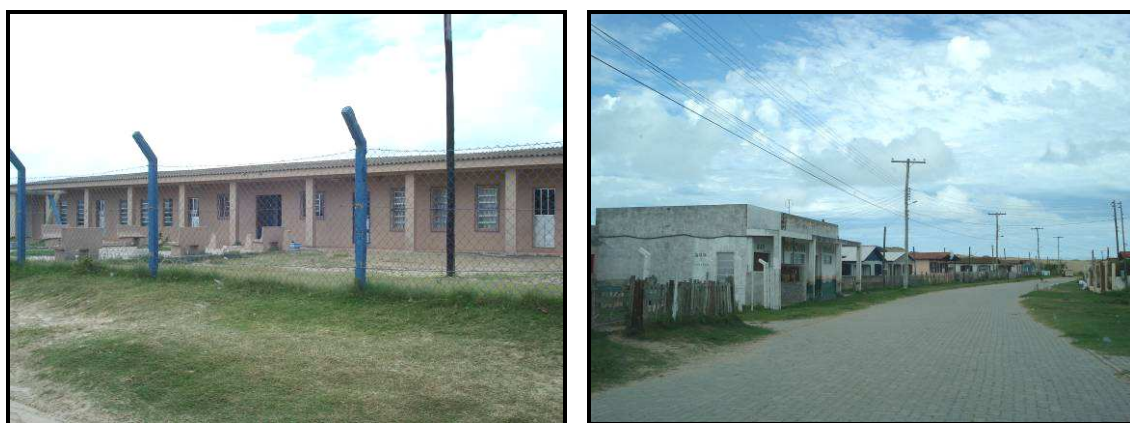
Figura 4.46-Escola de Estadual de Ensino Fundamental Silvério da Costa Novo na 5ª Seção da Barra à esquerda e a direita acesso pavimentado que liga o bairro ao centro.
