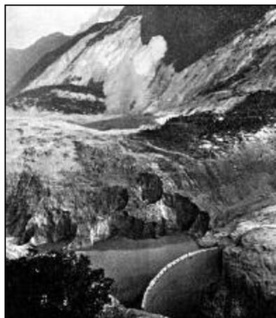
Figura 1.3 – Barragem em forma de arco e depósito de rocha A sua montante no Vale Vajont (Itália). Fonte: FRITZ, 2002.
