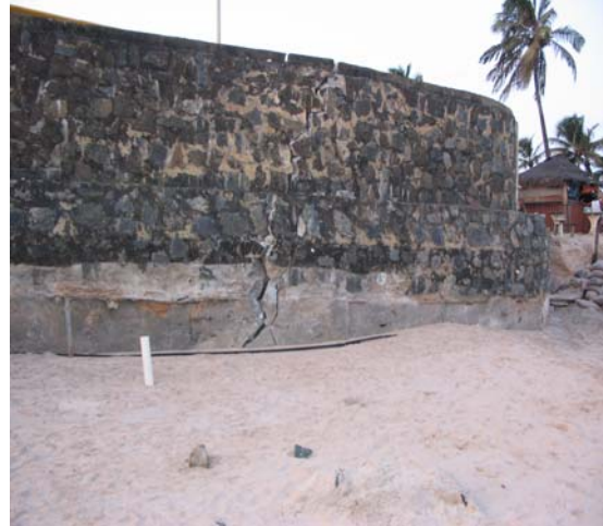
Foto A1.24 - JORNAL A TARDE: 24/09/2005 – CALÇADA DANIFICADA PELA MARÉ, ENTRE AS PRAIAS DE PLACAFORD E ITAPUÃ, AMEAÇA ÁREA DE BARRACAS ONDE FICAM BANHISTAS: A maré do último dia 23 destruiu 50 metros do calçamento, também causou desmoronamento da alvenaria que dá suporte às barracas e destruiu completamente uma escada, que agora é bloco de pedra solta na praia, além de causar danos a mesas e cadeiras de barracas de praia.
