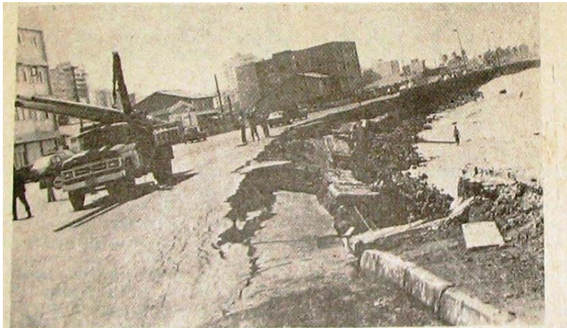
Na Avenida Otávio Mangabeira, trecho da Pituba, a ressaca e os ventos solaparam o asfalto e derrubaram postes
