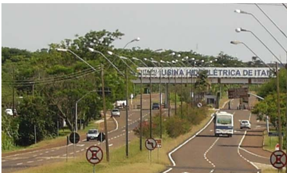
Foto 2. Barreira de controle na entrada da Usina de Itaipu
