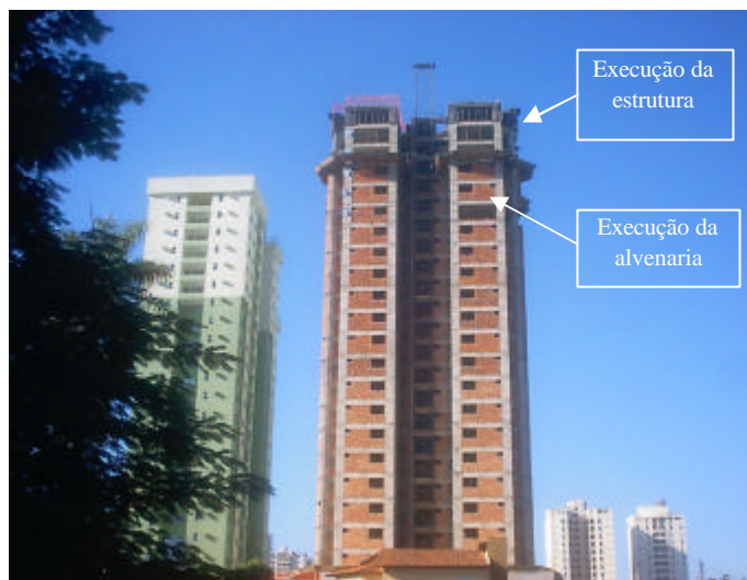
Figura 5.1 – Aspecto externo da obra geradora do RCD utilizado para a produção de concretos com AGR.
