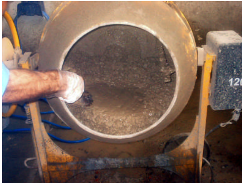
Figura 5.13 – Verificação do teor de argamassa.
