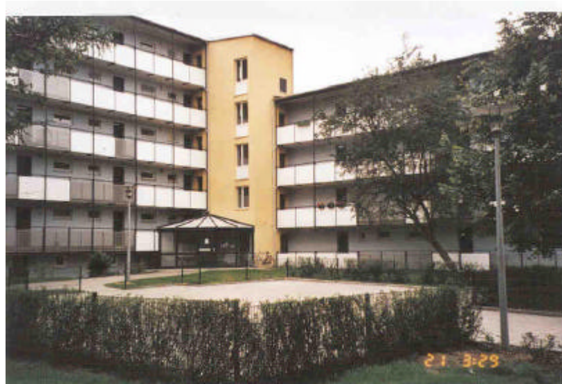
Figura 3.2 – Condomínio em Hamburgo, com 460 unidades, construído com concreto de agregados reciclados há 50 anos (KROPP, 2000 apud LEVY; HELENE, 2002).
