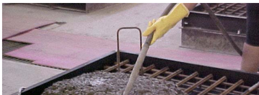
Figura G.2 – Lançamento do concreto na forma
