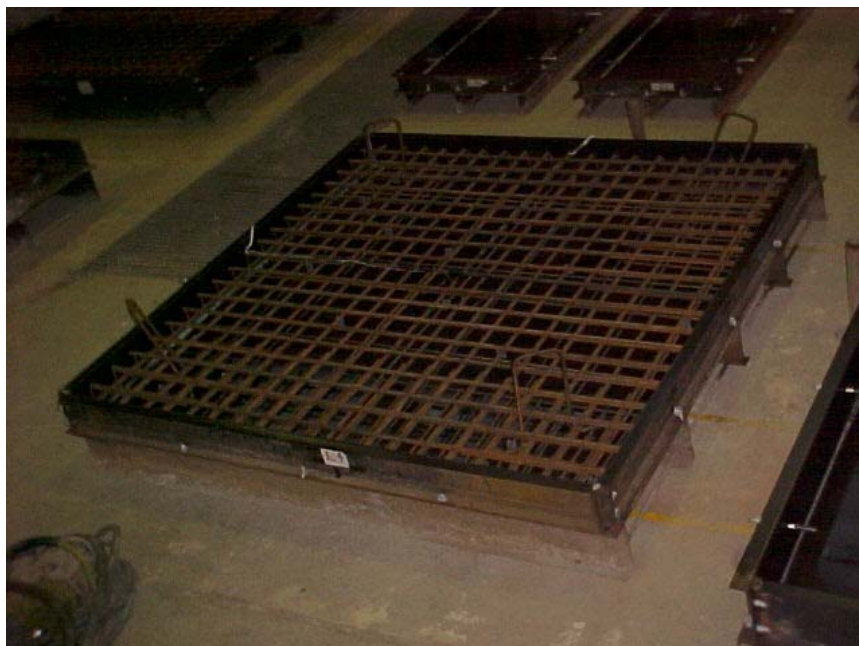
Figura G.1 – Forma montada para concretagem
