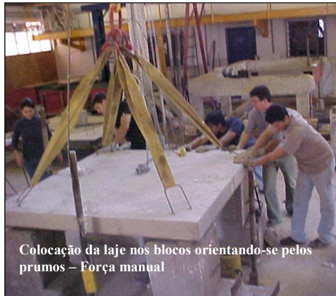
Figura 3.8 – Detalhes do processo de posicionamento das lajes
