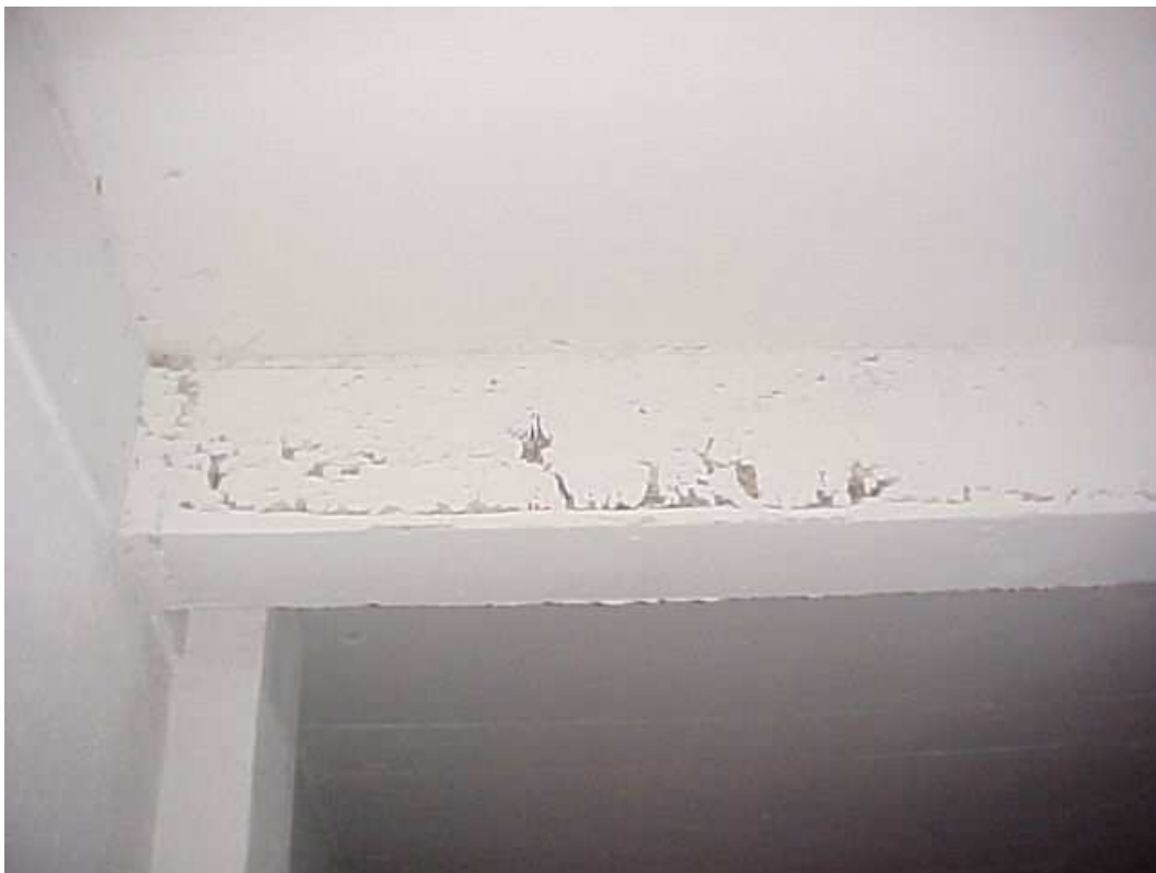
Figura 3.20- Elementos em concreto armado com segregação.
